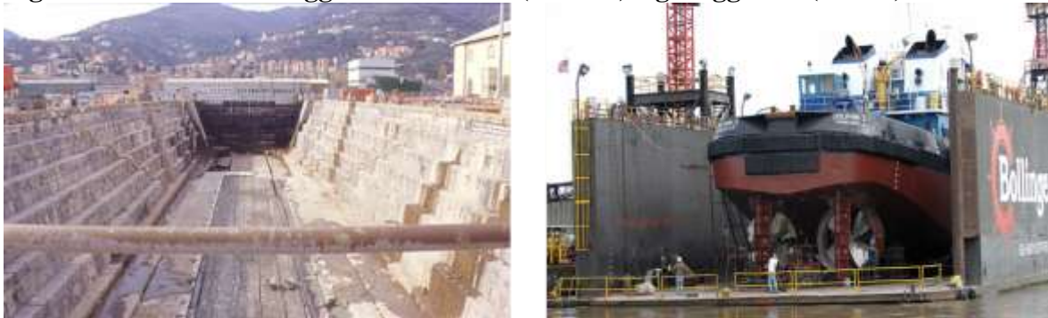
Fig. 41: bacino di carenaggio in muratura (sinistra) e galleggiante (destra)
